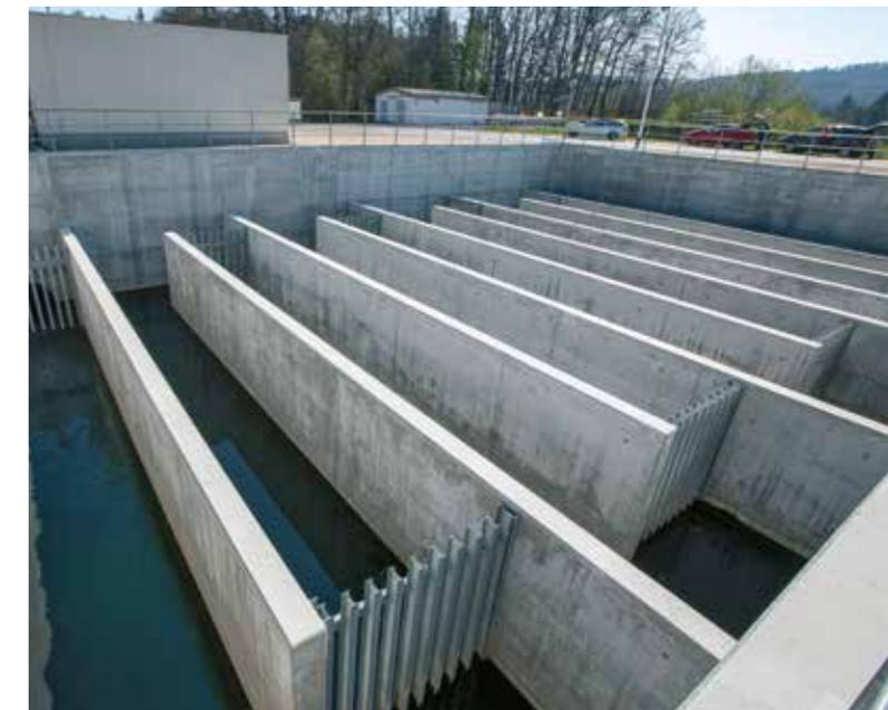
Neue labyrinthartige Verzögerungsbauwerke verlängern die Aufenthaltszeit des Wassers zwischen der Wasserbeprobung und der Einleitung in die Alz.
